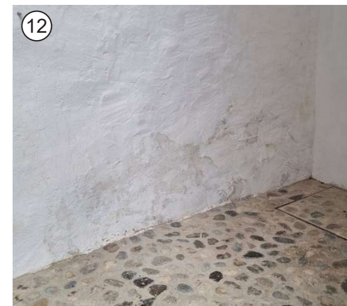
12 P - sanacija ometa na zunanjih stenah grajskega poslopja - izvedba hidrofobne bariere
