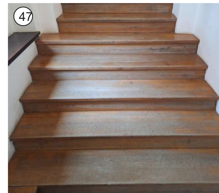
47 P+2 - lesena stopnišča v prostorih grajskega poslopja se obnovijo
