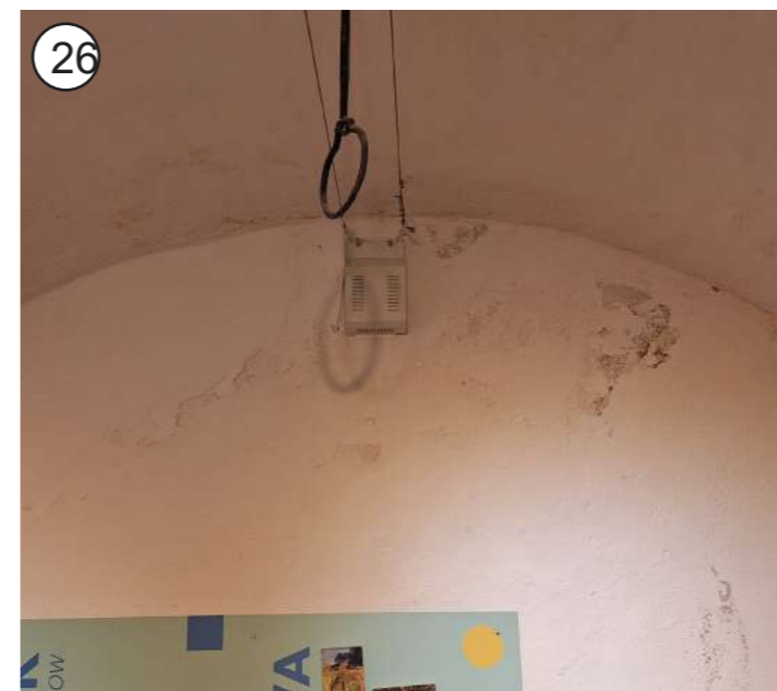
26 MEDETAŽA - sanacija ometa v notranjih prostorih grajskega poslopja
