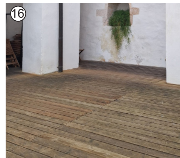
DVORIŠČE - dotrajan obstoječ lesen podij, se ga menja + sanacija ometa na zunanjih stenah grajskega poslopja - izvedba hidrofobne bariere
