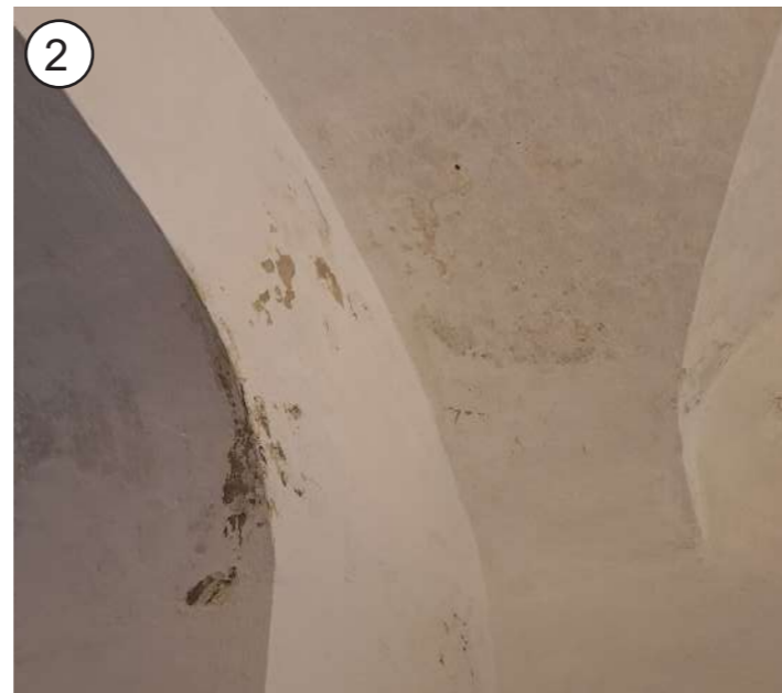
2 P - sanacija ometa v notranjih prostorih grajskega poslopja
