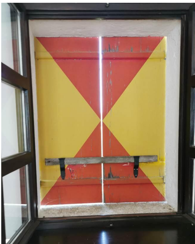
Obstoječa polkna – po tem vzorcu se jih zamenja z novimi.
