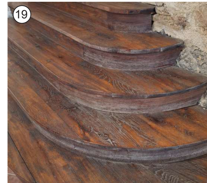
19 P - lesena stopnišča v prostorih grajskega poslopja se obnovijo
