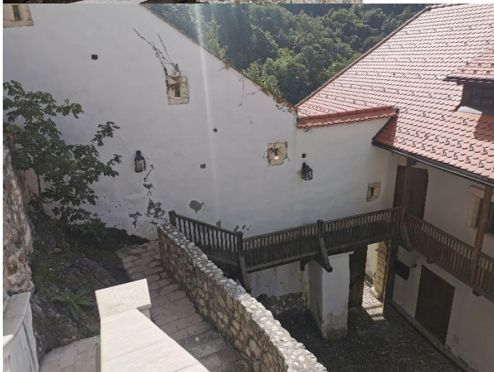
Obstoječa zunanja ureditev pri spodnjem gospodarskem poslopju. Izvedba lesenega podija in pergole (zgoraj) ter obnova ganka (spodaj).
