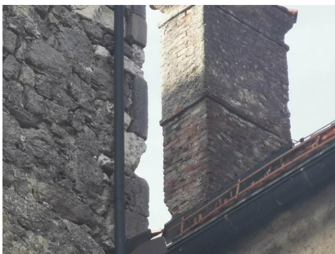
Obstoječe stanje dimnika na grajskem poslopju – sanacija.
