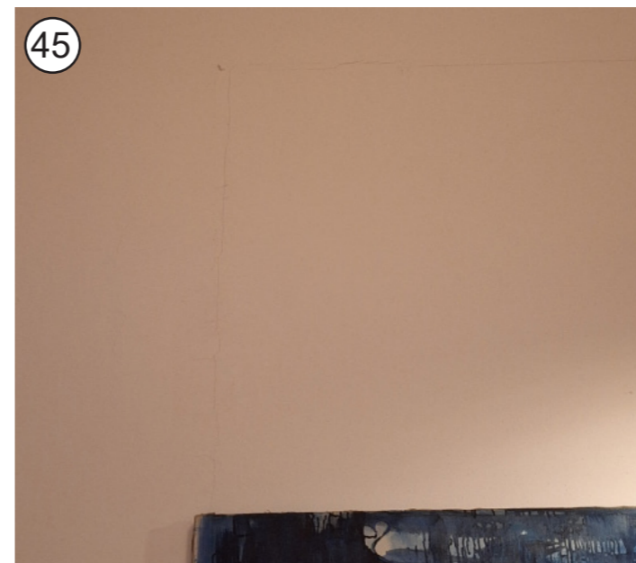
45 P+2 - odstrani se knauf, kjer so zazidana okna v razstavnih prostorih
