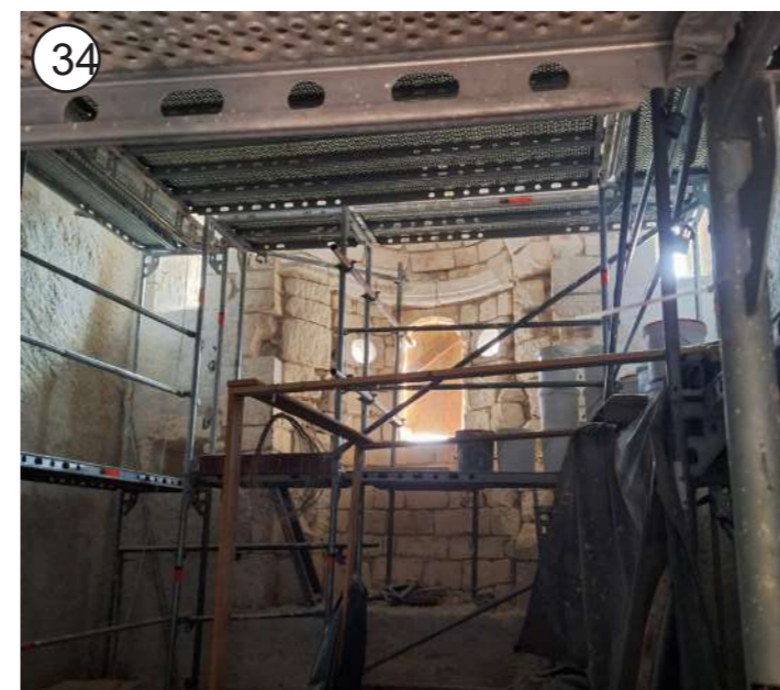
34 MEDETAŽA - sanacija ometa v notranjih prostorih grajskega poslopja
