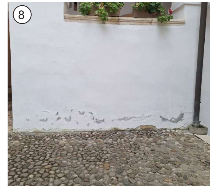
8 P - sanacija ometa na zunanjih stenah grajskega poslopja - izvedba hidrofobne bariere
