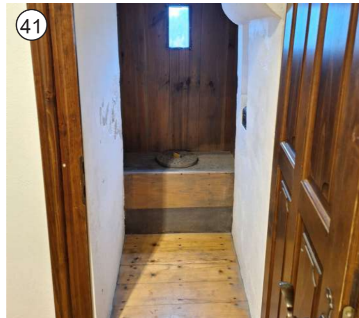
41 P+2 - sanacija ometa v notranjih prostorih grajskega poslopja
