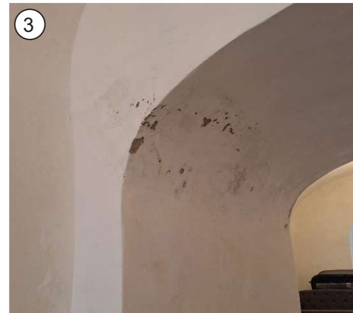
3 P - sanacija ometa v notranjih prostorih grajskega poslopja
