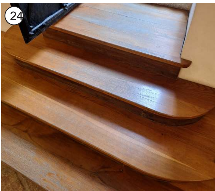
24 MEDETAŽA - lesena stopnišča v prostorih grajskega poslopja se obnovijo
