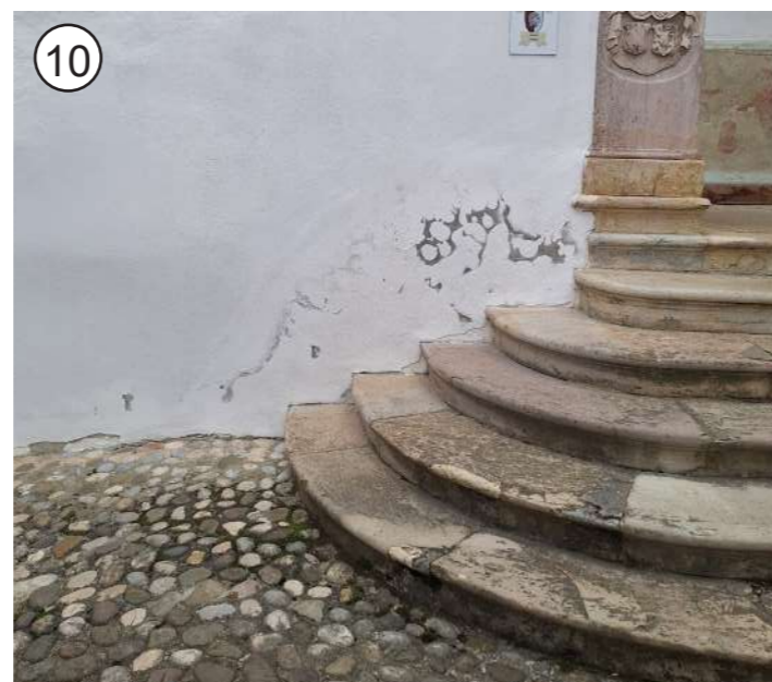
10 P - sanacija ometa na zunanjih stenah grajskega poslopja - izvedba hidrofobne bariere
