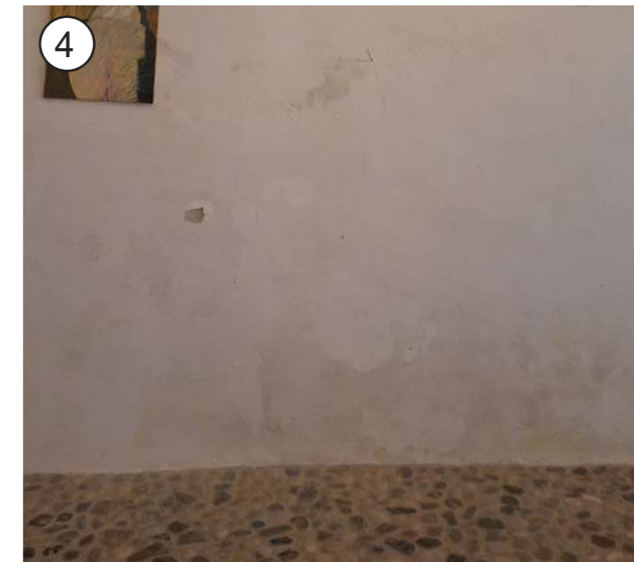
4 P - sanacija ometa v notranjih prostorih grajskega poslopja
