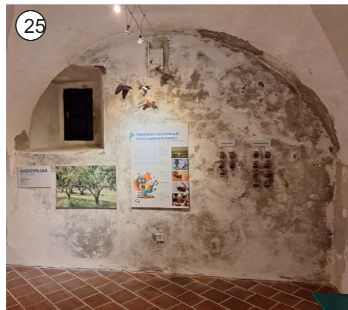
25 MEDETAŽA - sanacija ometa v notranjih prostorih grajskega poslopja
