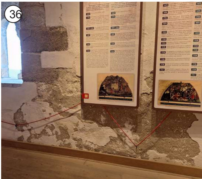
36 P+1 - sanacija ometa v notranjih prostorih grajskega poslopja
