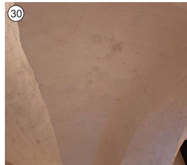
30 MEDETAŽA - sanacija ometa v notranjih prostorih grajskega poslopja
