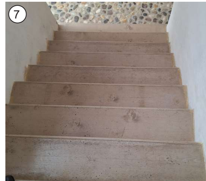
7 P - lesena stopnišča v prostorih grajskega poslopja se obnovijo
