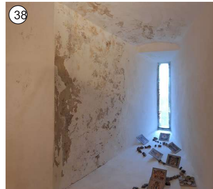
38 P+1 - sanacija ometa v notranjih prostorih grajskega poslopja
