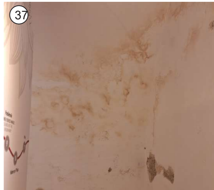
37 P+1 - sanacija ometa v notranjih prostorih grajskega poslopja
