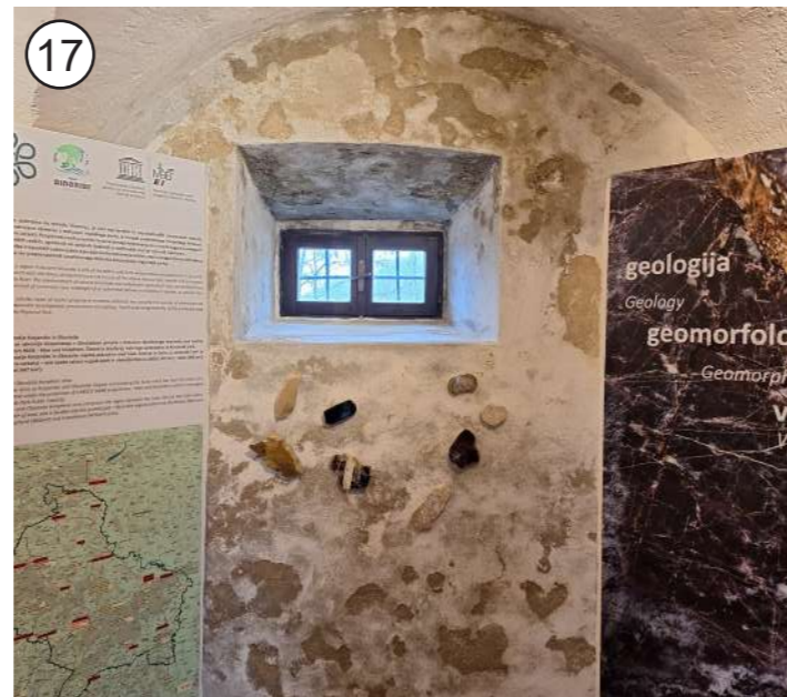
17 P - sanacija ometa v notranjih prostorih grajskega poslopja
