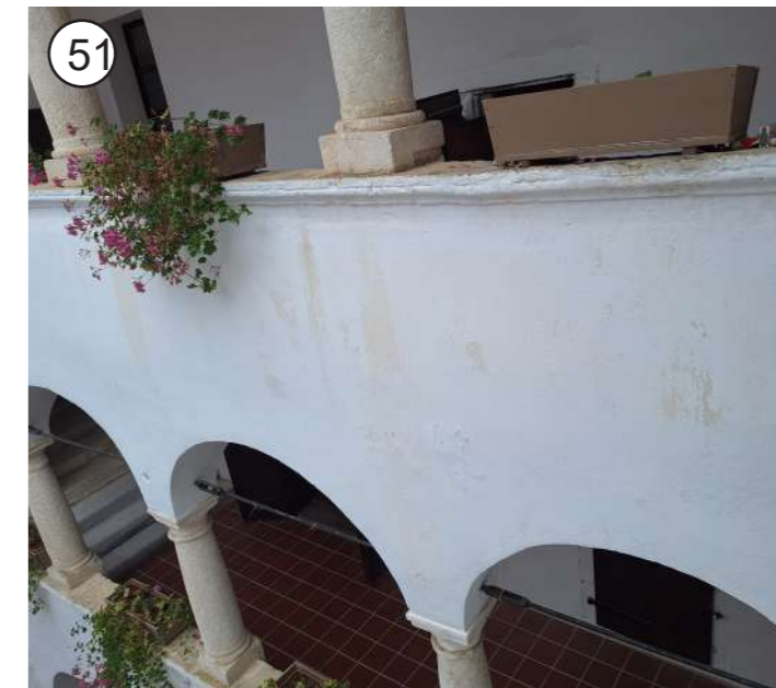
P+2 - sanacija ometa na zunanjih stenah grajskega poslopja - izvedba hidrofobne bariere
