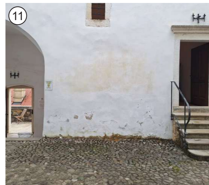
11 P - sanacija ometa na zunanjih stenah grajskega poslopja - izvedba hidrofobne bariere
