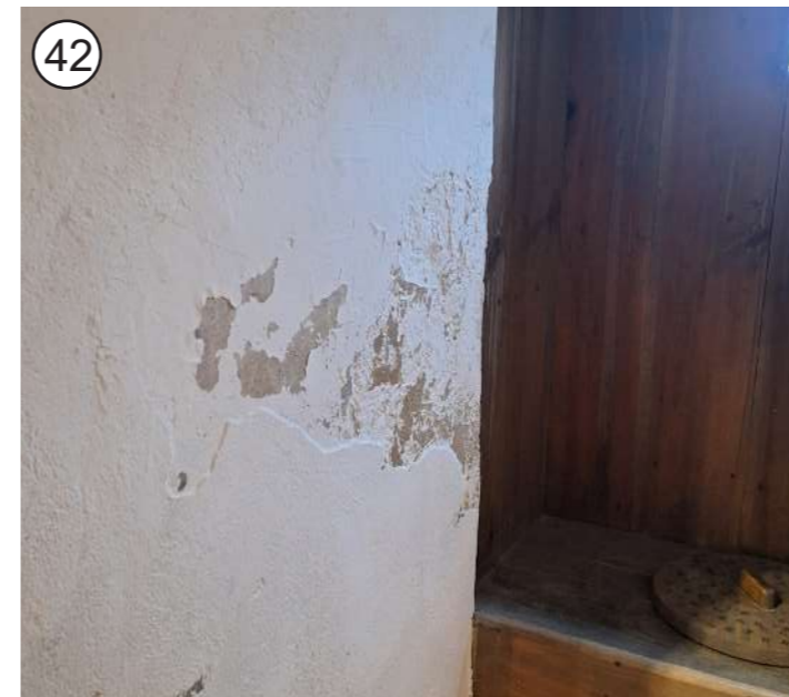
42 P+2 - sanacija ometa v notranjih prostorih grajskega poslopja
