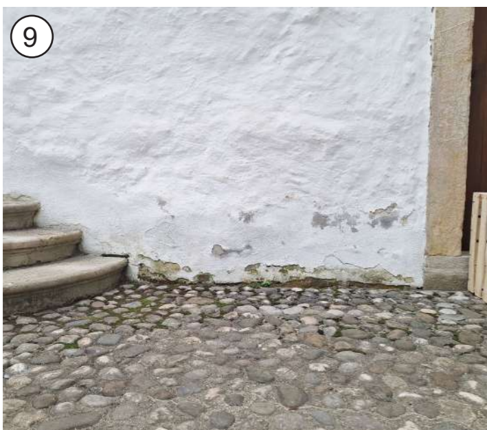
9 P - sanacija ometa na zunanjih stenah grajskega poslopja - izvedba hidrofobne bariere
