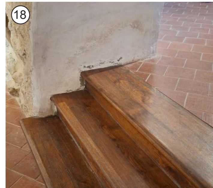
18 P - lesena stopnišča v prostorih grajskega poslopja se obnovijo
