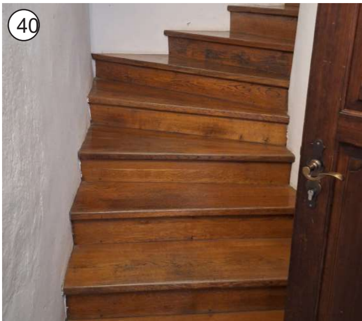
40 P+2 - lesena stopnišča v prostorih grajskega poslopja se obnovijo
