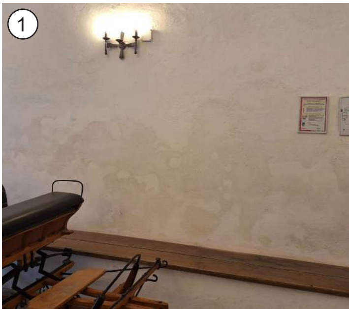
1 P - sanacija ometa v notranjih prostorih grajskega poslopja
