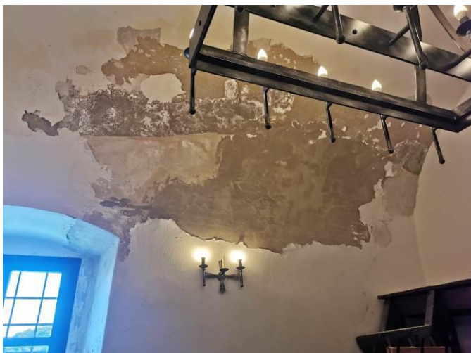
Ometi v prostorih grajskega poslopja , načeti zaradi vlage – sanacija ometov.
